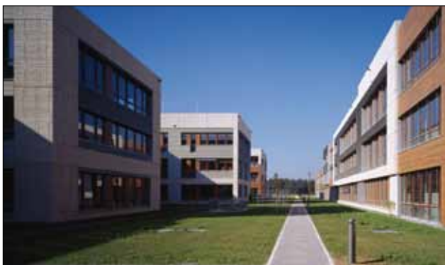
Het succes van energiebeheer voor verlichting in de Campeon gebouwen werd bekroond met de Energie-Efficiëntie award
