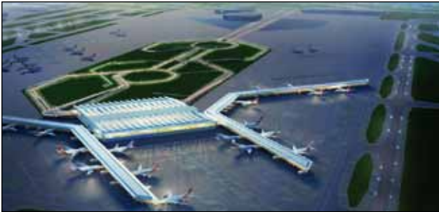
Op de nieuwe terminal van Delhi Airport, zorgen 100.000 armaturen en KNX voor een efficiënt verlichtingssysteem.
