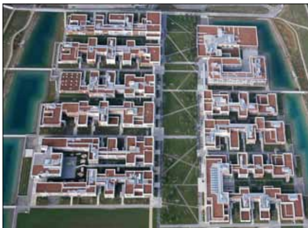
Zes servers verbinden de KNX "werelden" overeenstemmend met de gebouwzones voor verlichtingsbeheer.
