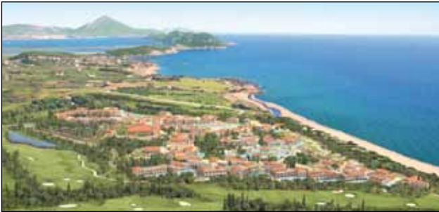
Het Navarino Resort heeft één van de meest uitgebreide KNX-installaties in Griekenland
